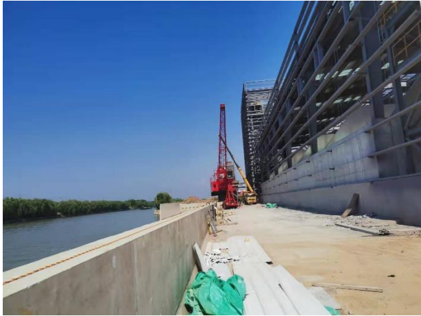
项目码头 1#作业泊位
