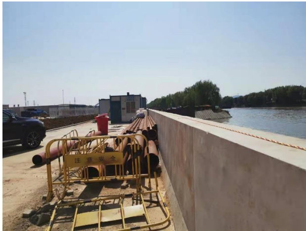
项目码头 2#待泊泊位
