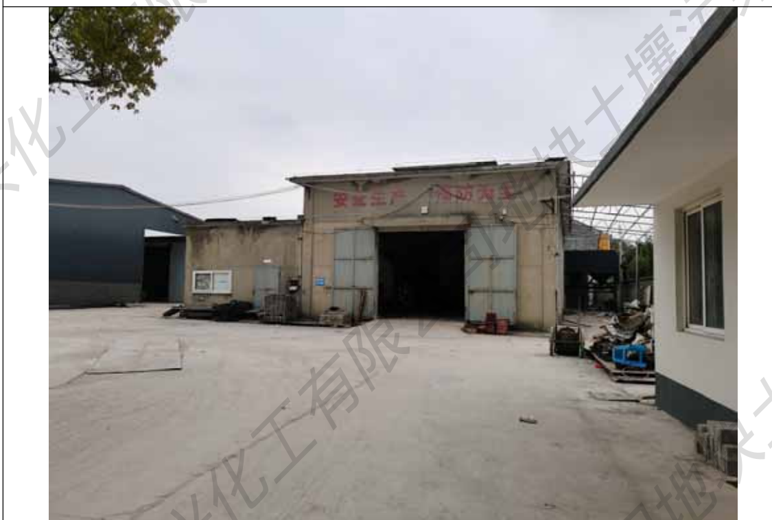
地块内西侧仓库，未拆除，现状为闲置状态
