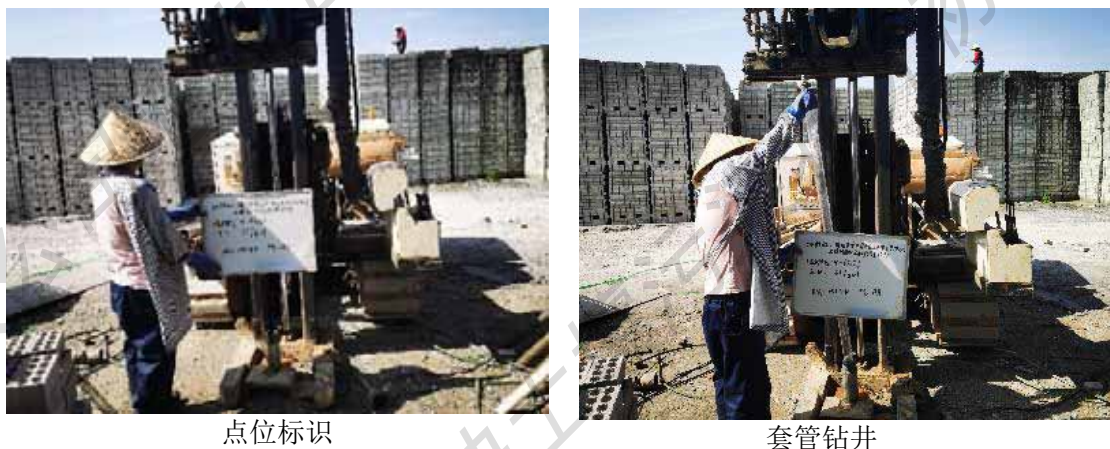
图 5.2-3 部分点位土壤现场钻探照片
