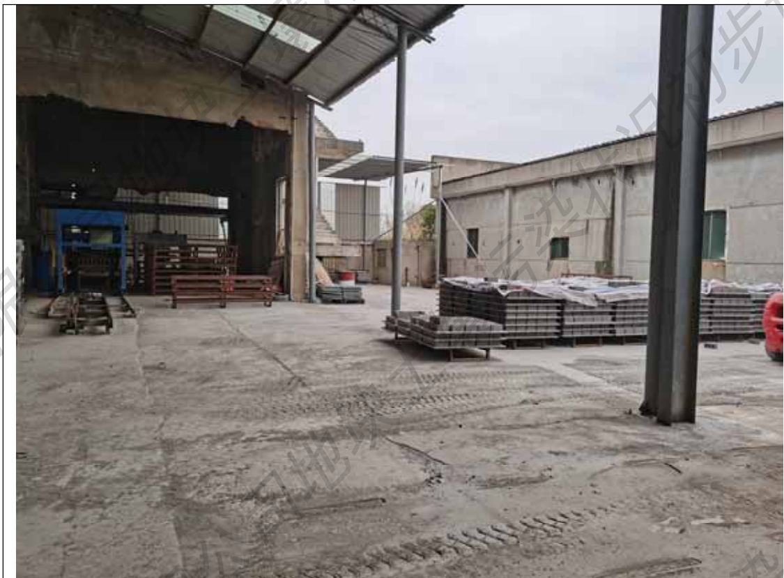
地块内南侧厂房已拆除
